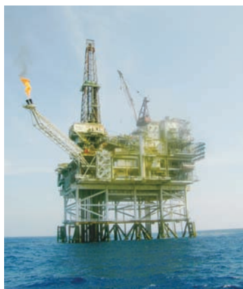
渤海湾海上石油井架
