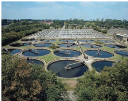
集中处理工业废水
